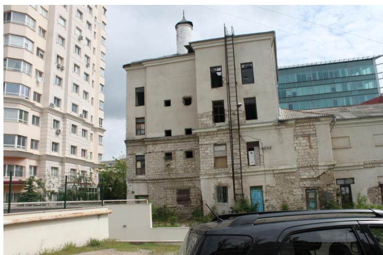
Figura 1. Clădirea abandonată a fostei fabrici de bere „Bohemia”
